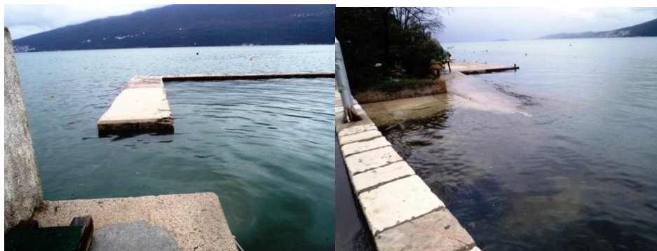
Figure 38. Inondations dues à une marée de tempête à Djenovici (municipalité de Herceg Novi)
