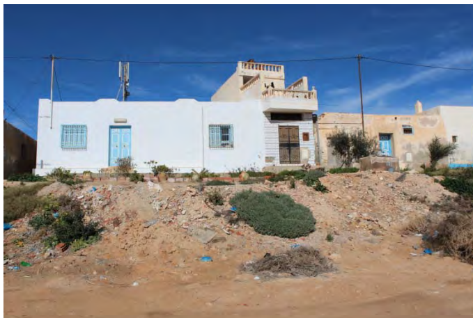
Figure 7 Remblai réalisé avec des déchets (photo GRID-Genève, 2015)
