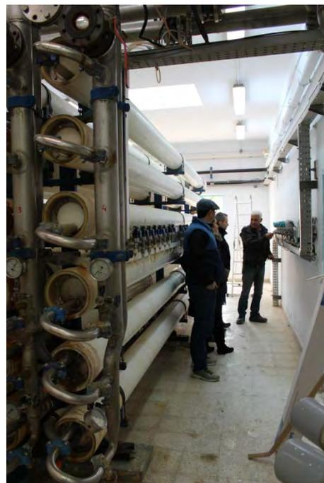
Figure 5 Station de traitement des eaux par osmose inverse (photo GRID-Genève, 2015)
