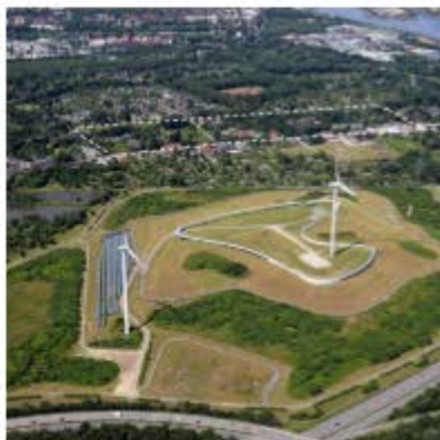
Energie Berg, Hamburg, DE
