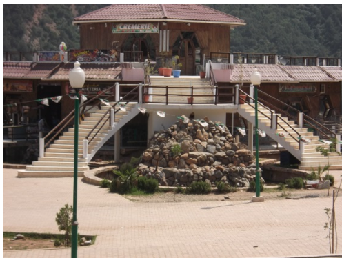
Photo 1 : Nouvelle aire de récréation aménagée par la commune (Scénario 3)
