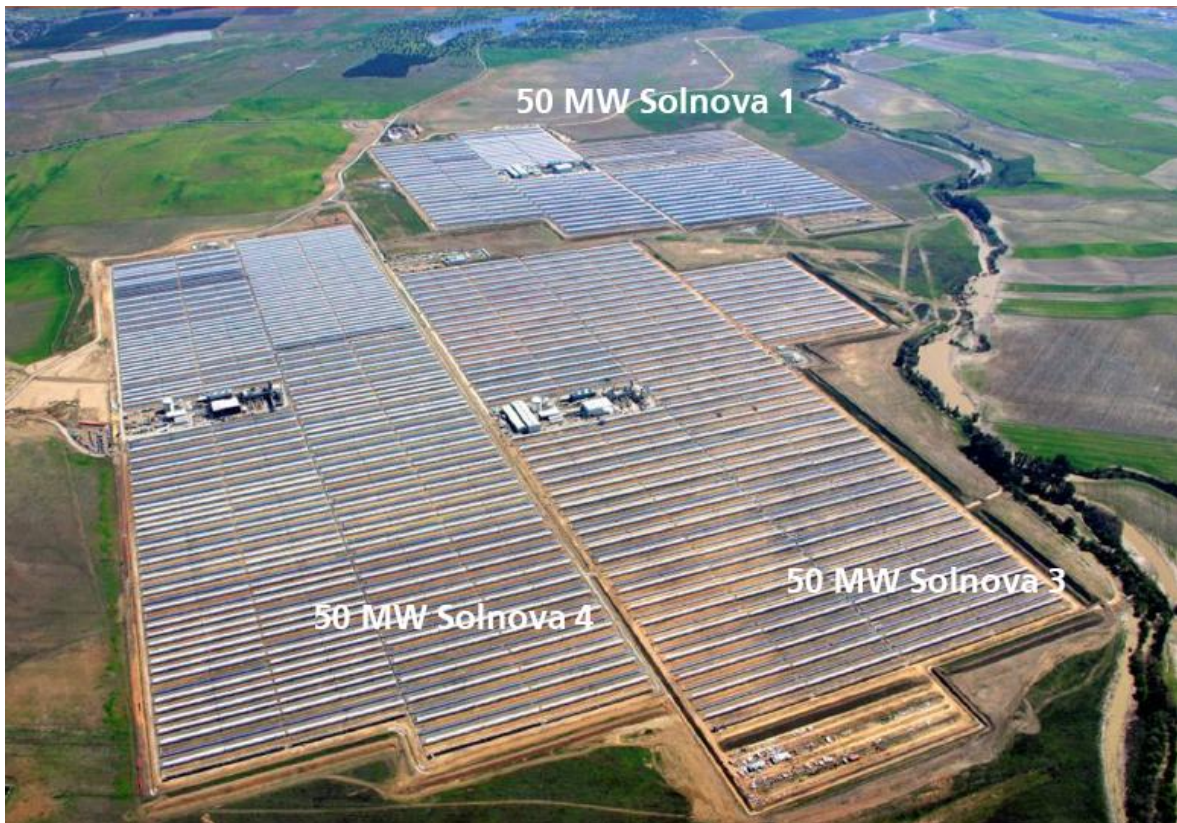
Figure 8 – Centrale solaire de Solnova, Espagne
