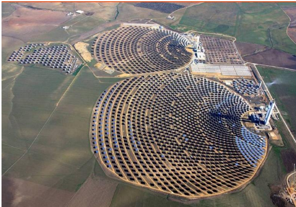
Figure 7 – Centrales solaires PS 10 et PS 20, Séville, Espagne
