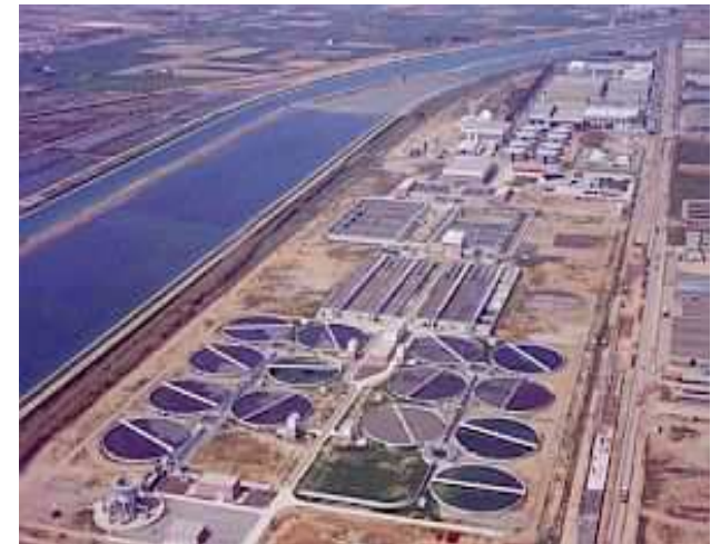
WWTP Prat del Llobregat (Cataluña) (Source: © Soliclíma 2005-2009)
